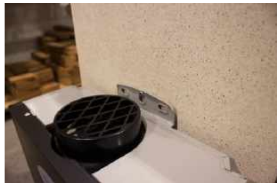
Gasovnen hængesop med en topskrue, der ikke er skruet helt ind
