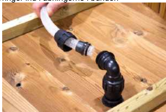
Fastgør slanger til gennemføringerne
