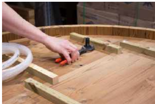
Skrue gasvarmerens indløb og returgennemføringer ind i åbningerne i bunden
