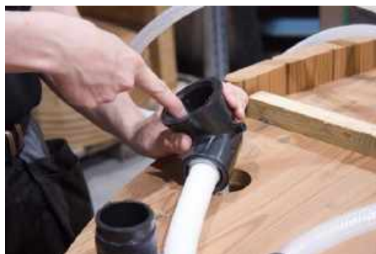
Påfør silikone på gevind
